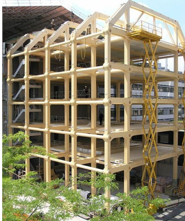
Structură de lemn Tamedia Office Building, arh. Shigeru Ban Architects, Zurich, Elveția, 2013
