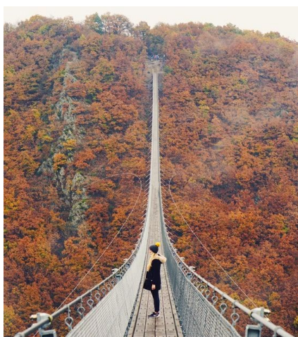
Hängeseilbrücke, Mörzdorf, Germania
